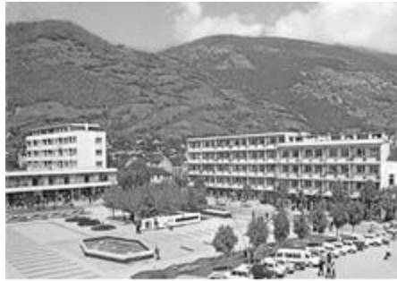
a. New city center
