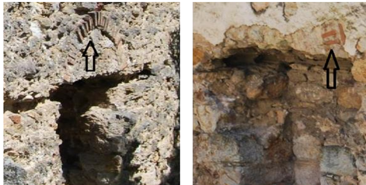
Figure 8. 9. Fazat e ndërtimit në xhaminë e Trepçës
